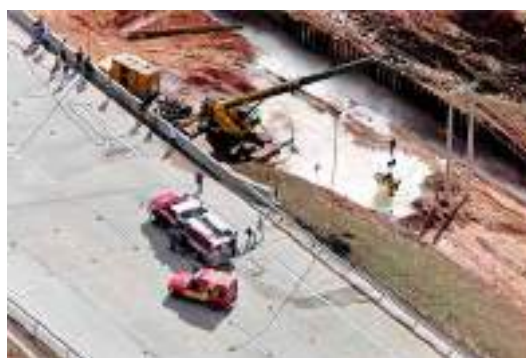
Figura 6 - Acidente em função do uso de referenciais geodésicos distintos
