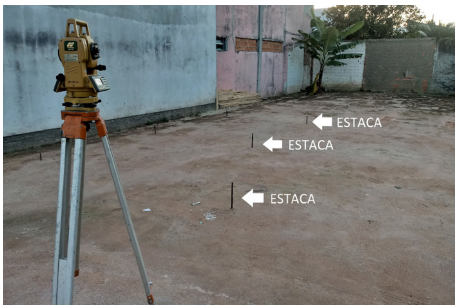
FIGURA 30 – LOCAÇÃO DE OBRA COM ESTACAS METÁLICAS
