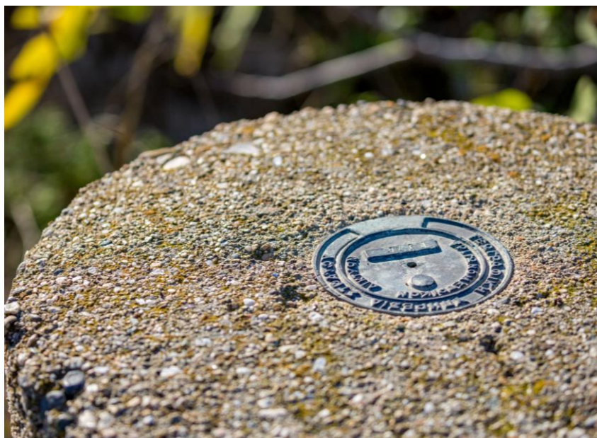
Figura 3 – Tipo de marco geodésico com placa metálica sobre base em concreto. Fonte: Shutterstock.
