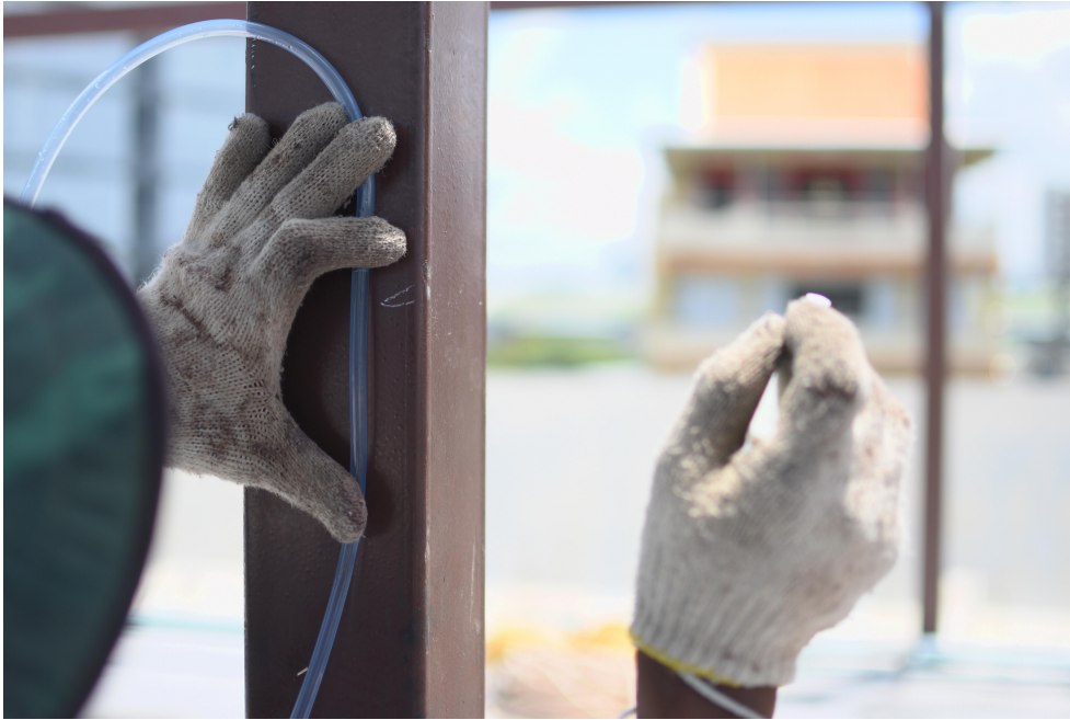
Figura 1 – Uso de nível de mangueira.
